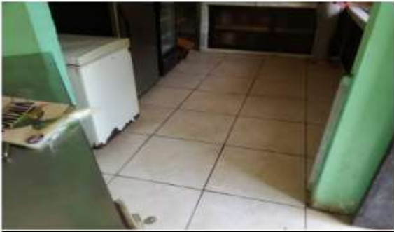
Ilustración 7 colocación de cerámica.
