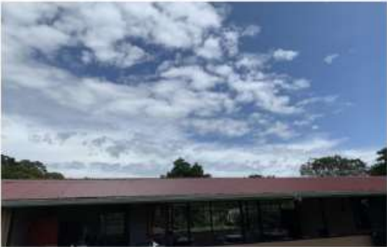
Ilustración 10 Construcción del techo y canoas
