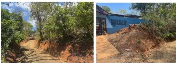
Foto1. Frentes de Trabajo Río Verde, Espavelar, El Socorro.
