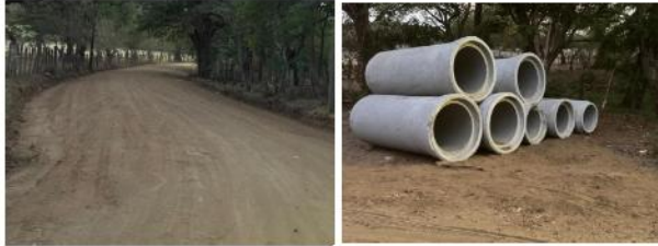
Foto 3. Trabajos en la zona de Bolsón.
