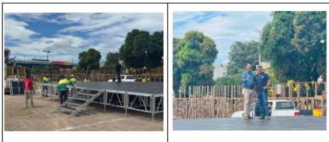
Fotos 1. Inspección Plaza López.
