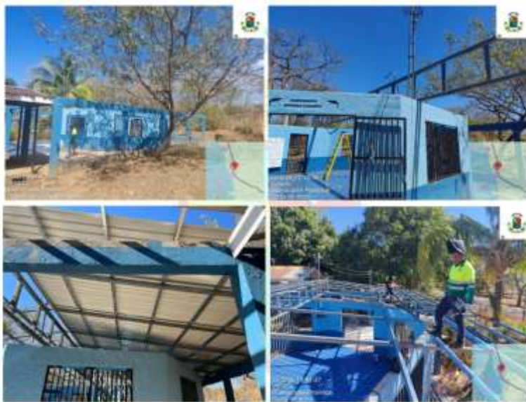
foto 5. Trabajos de cambio de techo en la Escuela Lagarto.
