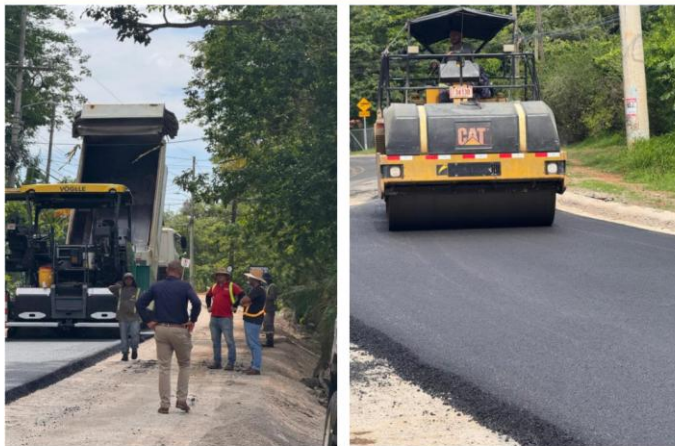
Ilustración 19 Inspección caminos y labores de asfaltados.
