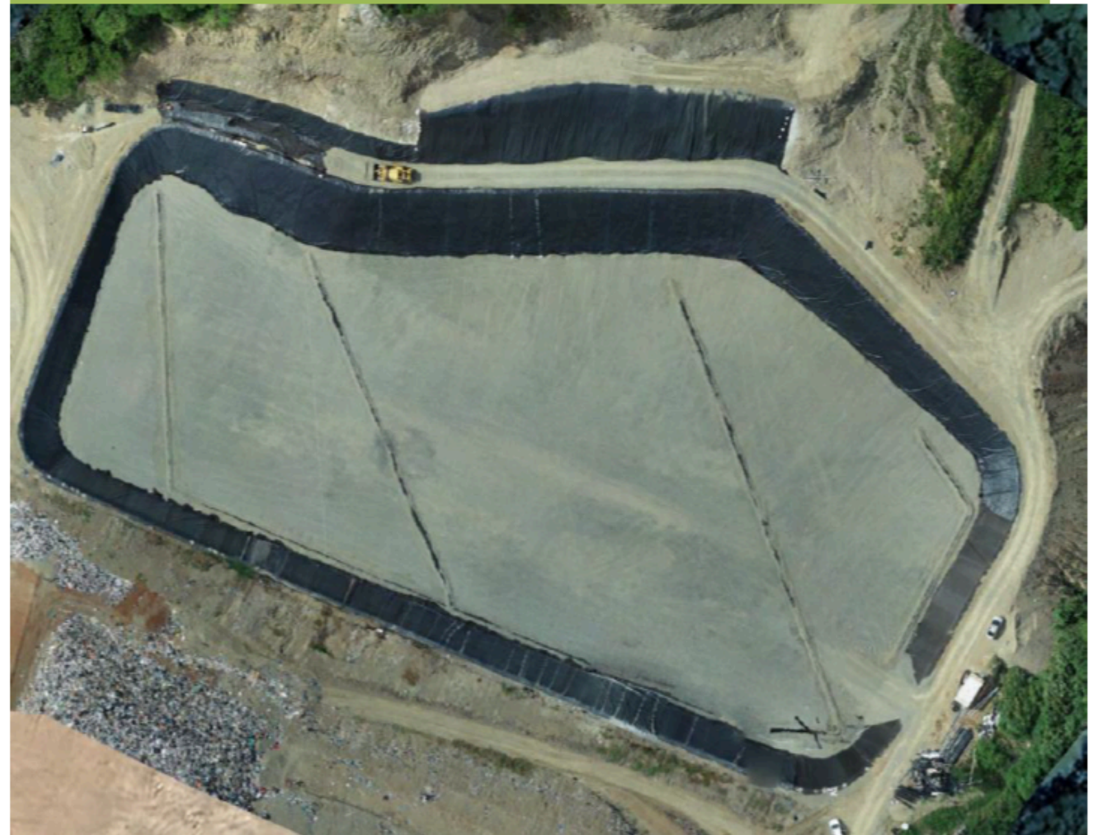
Foto 1. Proyecto de Construcción de la Celda 3, Parque Tecnológico Ambiental
