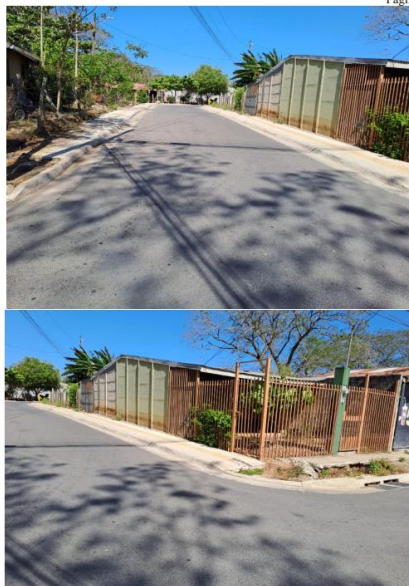
Figura 13. Fotografías tomadas el 01 de marzo de 2024. Muestra sitio de inspección de labores realizadas en campo, sector Barrios Las Maravillas.
