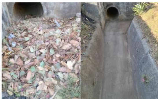
Figura 15. Fotografías tomadas el 27 de febrero de 2024. Muestra labores de limpieza antes y después en el canal del Cacao.
