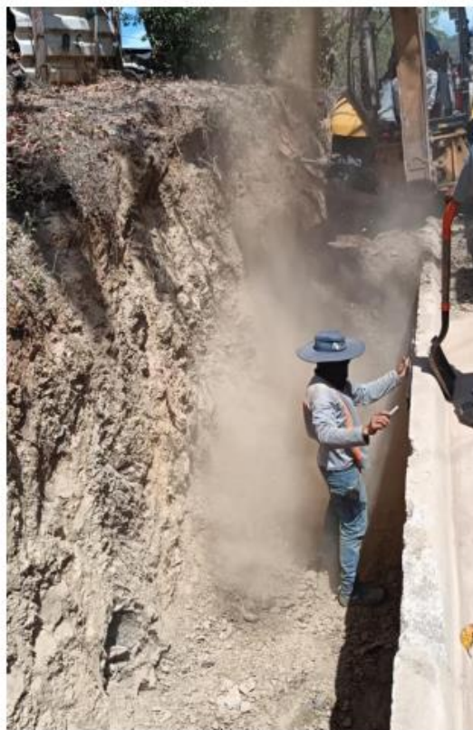
Foto 13. Inicio de trabajos en 27 de abril para el desfogue de aguas pluviales, se hizo demolición de la acera existente, para luego comenzar a gavetear y colocar un tubo de 600 mm a lo largo de 116 m lineales ha habido atrasos.
