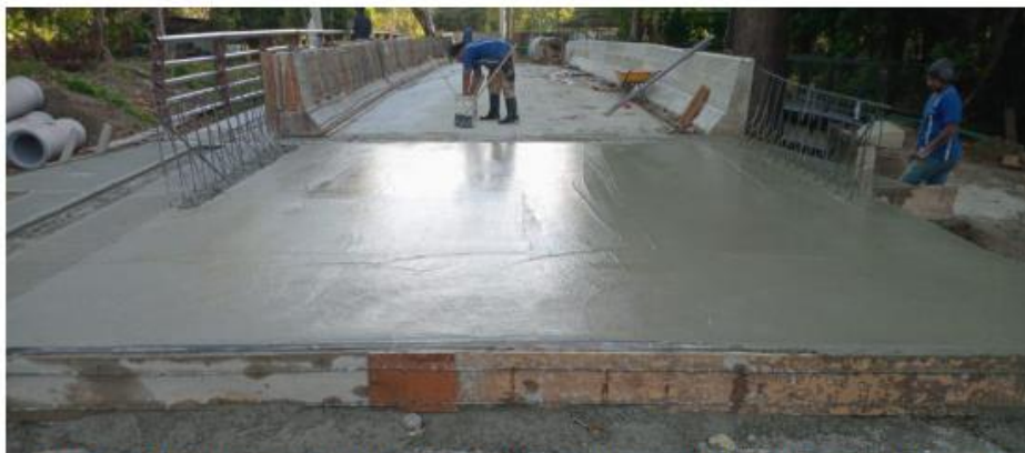
12. Foto 14. Construcción de viga de aproximación, colocación de tubos para encausar aguas pluviales, Quebrada Guape.
