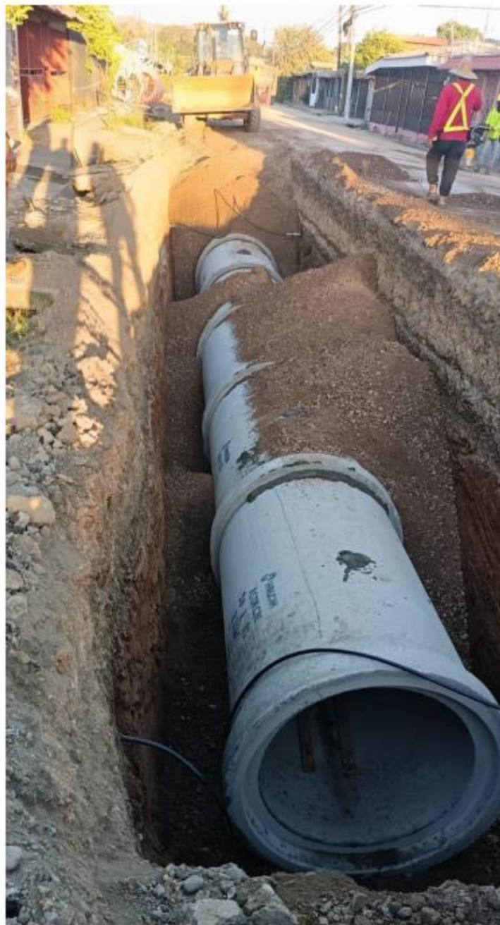
Foto 12. Se coloca 8 alcantarillas de 1200 mm en Barrio Panamá.
