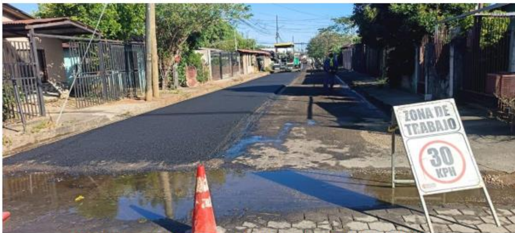
Foto 7. Recarpeteo en Barrio Tenorio con un espesor de 5 cm x 7 m de ancho.
