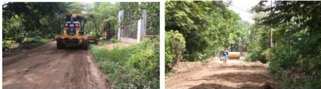
Foto 7. Trabajos en Tempate.
