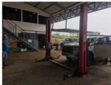
Figura 11. Equipo de elevación del Taller de Servicios Urbanos.
