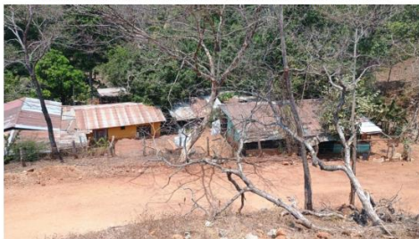
Figura 3. Fotografía tomada el 04 de abril muestra las casas que podrían verse afectadas por la caída de material y aguas por el movimiento de tierra en la comunidad de El Llano.
