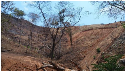
Figura 2. Fotografía tomada el 04 de abril donde muestra el movimiento de tierra sin permisos municipales realizados en la finca 156673-000 en la comunidad de El Llano.
