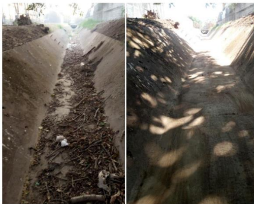
Figura 9. Fotografía tomada el 02 de abril de 2024. Limpieza del canal del Cecudi Rinconcito feliz.
