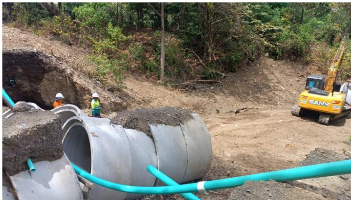
Foto 6. Continuación de los trabajos en San Pedro de Santa Bárbara con el movimiento de tuberías de concreto.
