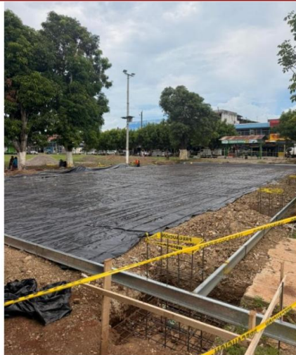
Foto 13. Inspección Plaza Los Mangos.
