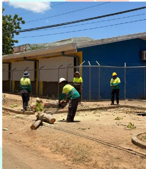
Foto 2. Inspección labores de la Cuadrilla y Maquinaria Municipal.
