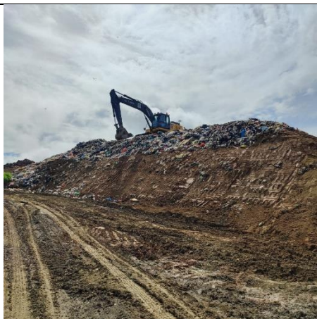
Figura 21. Cobertura de taludes en el sector suroeste de la celda 1.
