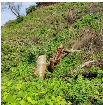
Figura 20. Corta de árboles en el área donde se construirán las celdas 3 y 4.
