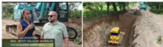
Foto 1. Inspección en San Pedro de Santa Cruz.
