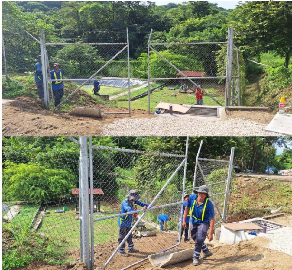
Fotografías 15. Muestra las labores de reparación de la malla ciclónica de la Planta de Tratamiento de Aguas Residuales del PTA.
