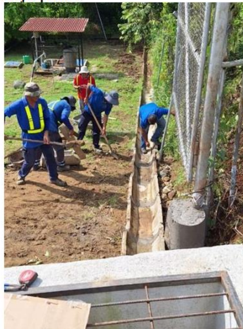
Fotografía 14. Muestra las labores de reparación del sistema de evacuación pluvial del PTA por parte de los funcionarios municipales.
