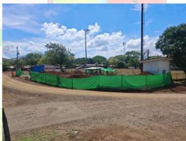
Foto 8. Labores de construcción del Salón Comunal San Juanillo.
