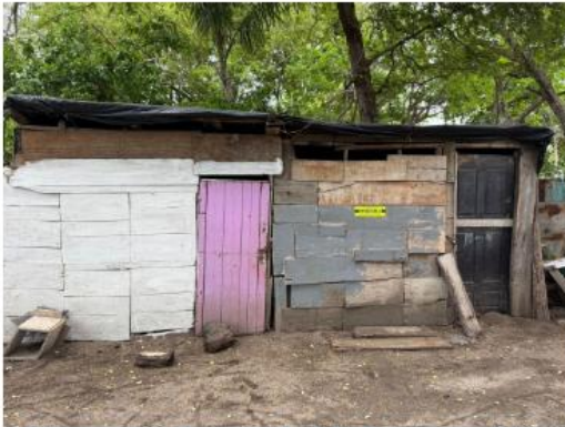
Foto 3. gira conjunta con el Departamento de Zona Marítimo Terrestre, Inspectores y Policía Municipal por la zona costera y sus alrededores en el cantón.
