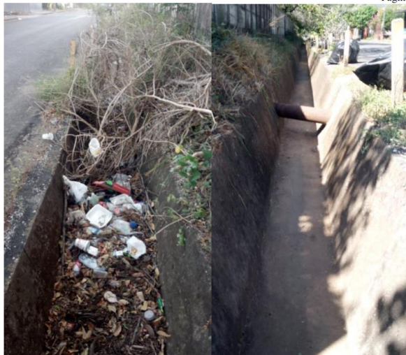
Figura 4. Fotografías tomadas el 06 de febrero del 2024. Muestra el antes y después de la limpieza del canal del AYA.
