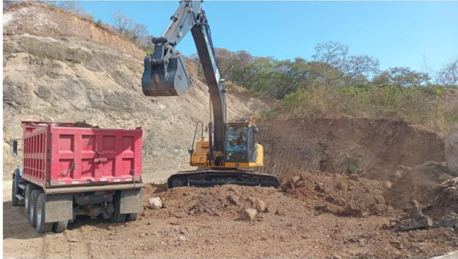
Figura 24. Excavadora municipal iniciando labores ordinarias en el PTA.
