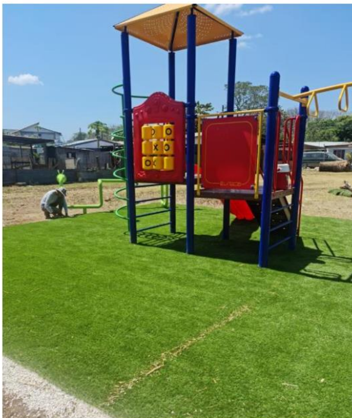
Figura 8. Fotografía tomada el 15 de febrero del 2024. Muestra la instalación de césped sintético en área de juegos de Barrio Las Maravillas.
