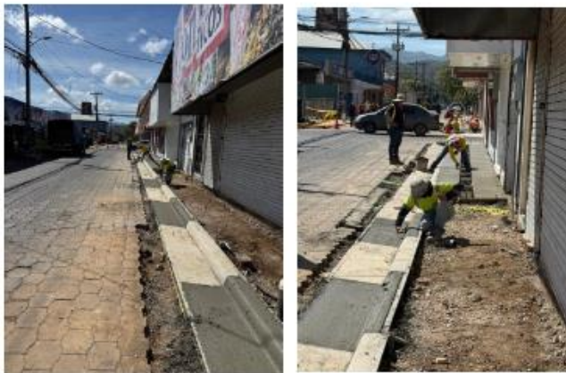
Foto 5. Se continúa con el trabajo de las aceras en el centro de Santa Cruz
