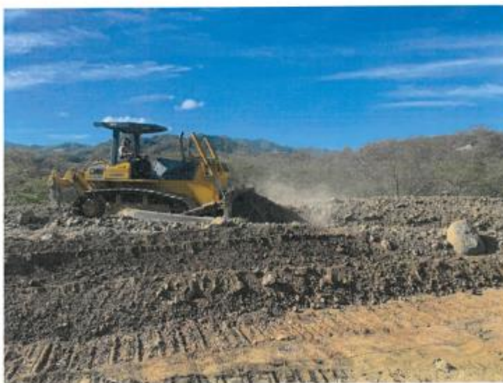
Imagen 5 (Extracción de apilamiento de material en el tajo ubicado en la comunidad de Diria)
