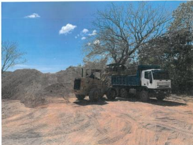
Imagen 6 (Extracción y acarreo de material en el taco ubicado en el Mojal, en Huacas de Santa Cruz.)
