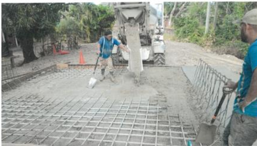
Imagen 4 (Construcción de loza de aproximación y colocación de lastre para rellenos de aproximación en Quebrada Guspe en la comunidad de Potrero).
