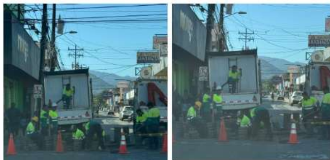
Foto 2. Inspecciones de labores de la cuadrilla municipal.
