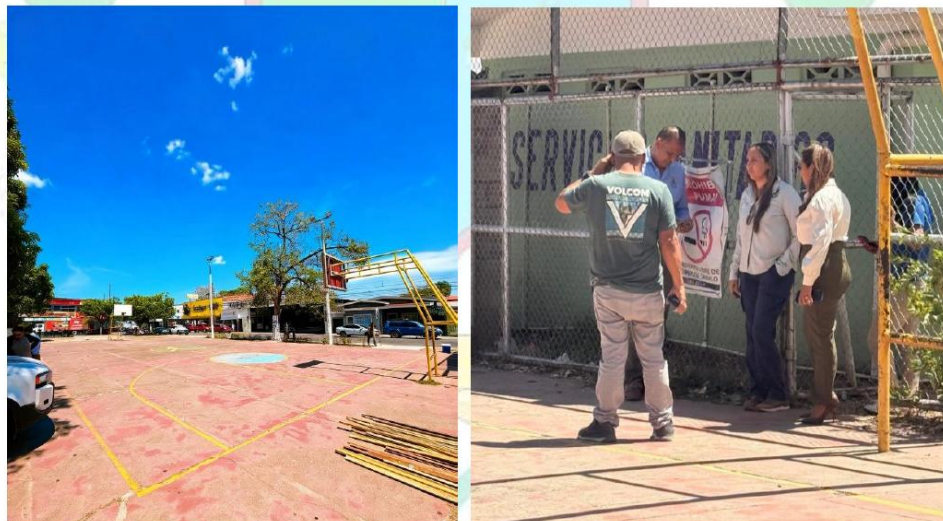
Foto 5. Inspección Plaza Los Mangos, Cancha de Básquet.
