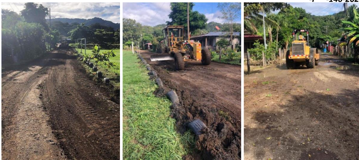
Figura 2. Labores de mantenimiento en el camino C5-03-270 Las Delicias
