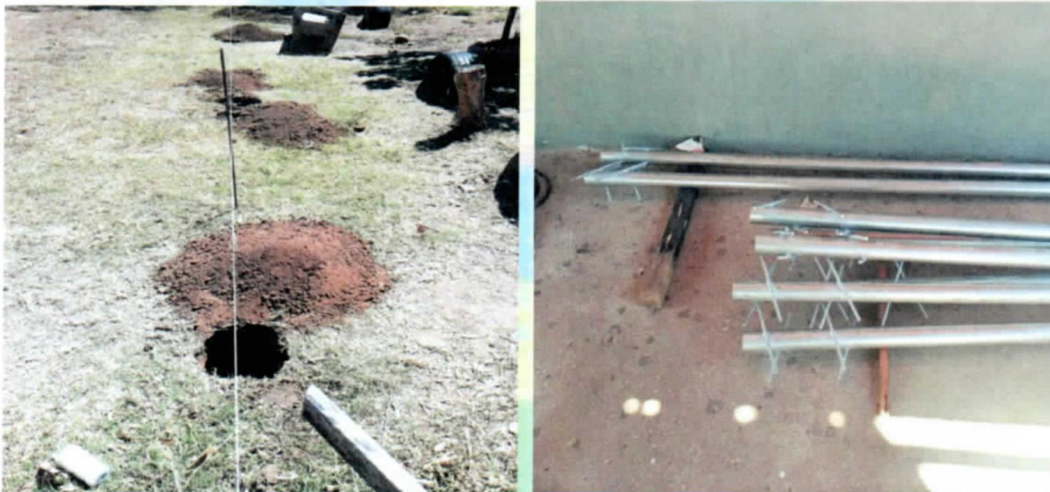
FOTO N°1, N°2. Trazo, zanqueo y confección de postes para la colocación de malla ciclón.
