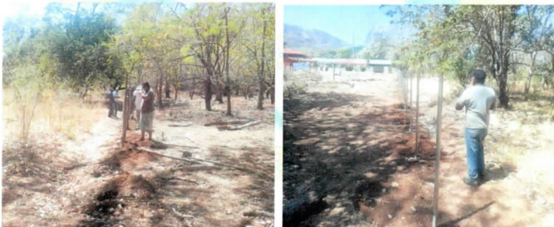
FOTO N°1, N°2. Eliminar cerca existente, trazo y colocación de tubos para malla.
