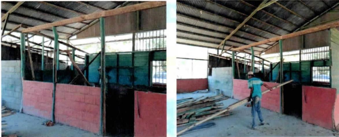
FOTO N°1, N°2. Desmontaje de toda la estructura existente, para dar inicio a las mejoras.
