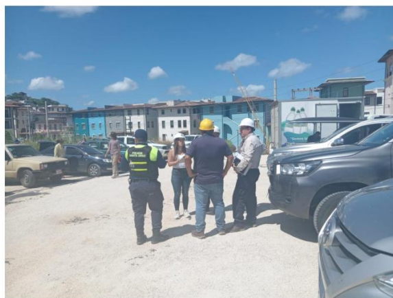
Fotos 10. Inspección CGR, Inspectores, Construcciones y Policía Municipal.
