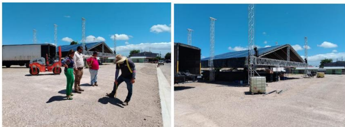
Foto 9. Inspección Labores y Logística Plaza López.
