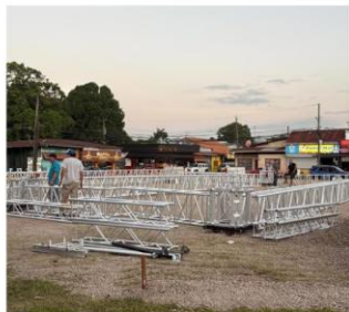
Foto 7. Inspección Plaza Los Mangos.
