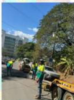
Foto 3: Inspección de los diferentes frentes de trabajo de la cuadrilla municipal.
