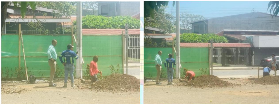
Foto 12. Inspección Plaza Los Mangos, Cancha de Básquet.
