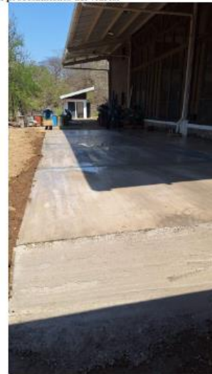
Figura 14. Losa de concreto en el costado sur del CRRV.
