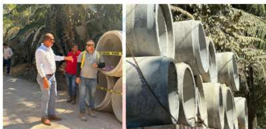
Foto 2. Visita Trabajos en Pinilla.
