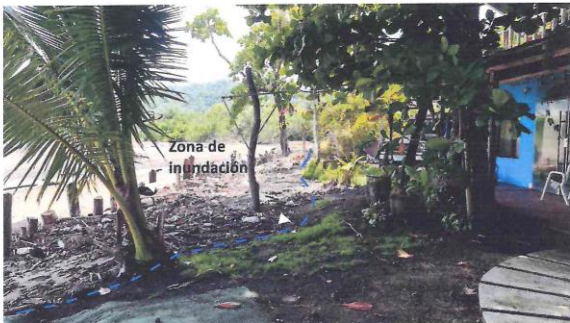
Foto 2. Muestra la afectación por inundación de una propiedad privada ubicada en la margen izquierda de la desembocadura del río Zelaya parte externa del meandro.
