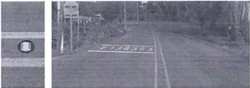
Fotografía 3. Captaluzes colocados sobre Ruta Nacional N° 160.
