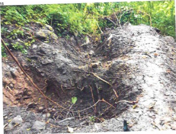
un hueco en apariencia para colocar la alcantarilla para tanque séptico.
