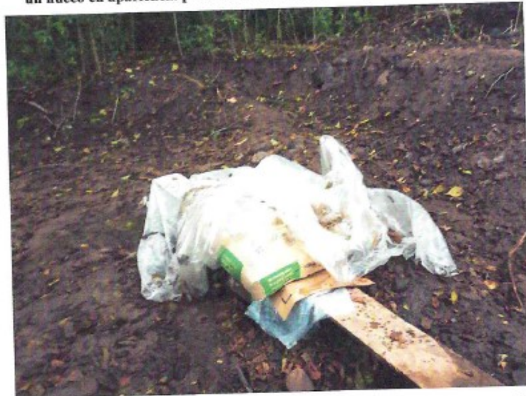
Unas tablas de formaleta y en cima de ellas un saco de cemento tapados con un plástico
