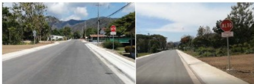
Figura N° 4 Ruta Nacional N° 160, sector Iglesia Católica
