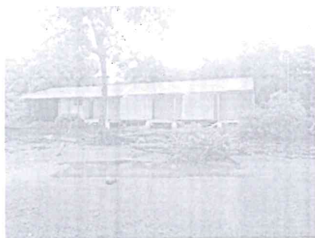
Construcción sin permisos zona de riesgo.
