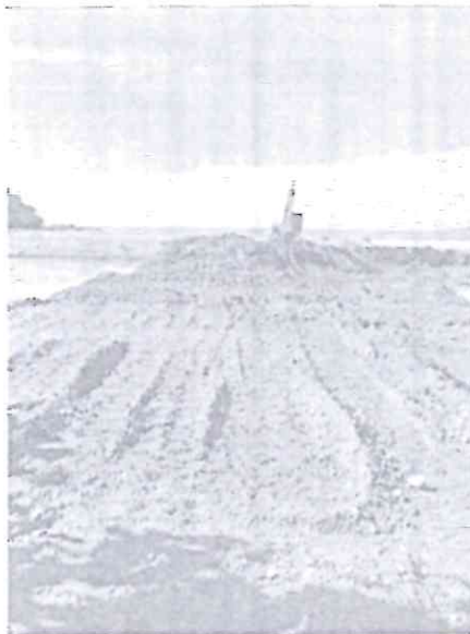
Construcción muro contención
