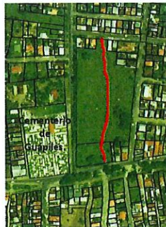
Imagen N°1: Se observa en rojo canal donde se presenta la problemática denunciada.
