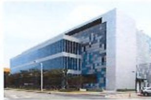
POSCO Data Center
