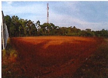
Conformación cancha La Fortuna
