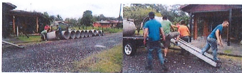
Figura 6. Entrega de alcantarillas a vecinos de Calle Israel. Fuente propia.
