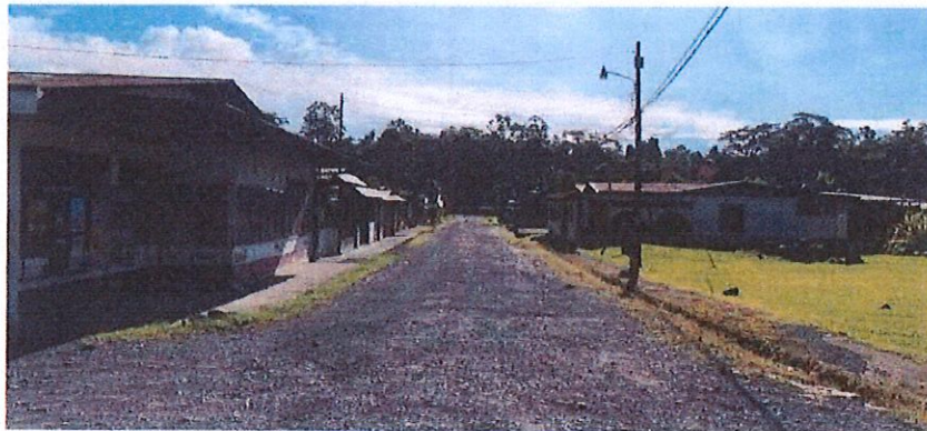
Figura 17. Fotografía al inicio de la calle C (vista hacia el este).
