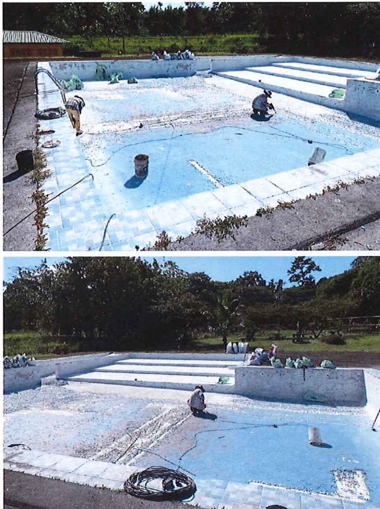
Figura 9.- Proceso de rehabilitación de Piscina Pedagógica
