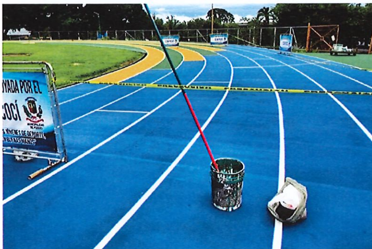
Figura 1.- Limpieza y colocación de revestimiento en la pista de atletismo
