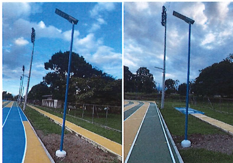
Figura 7.- Proceso de colocación de iluminación complementaria – Pista Atletismo
