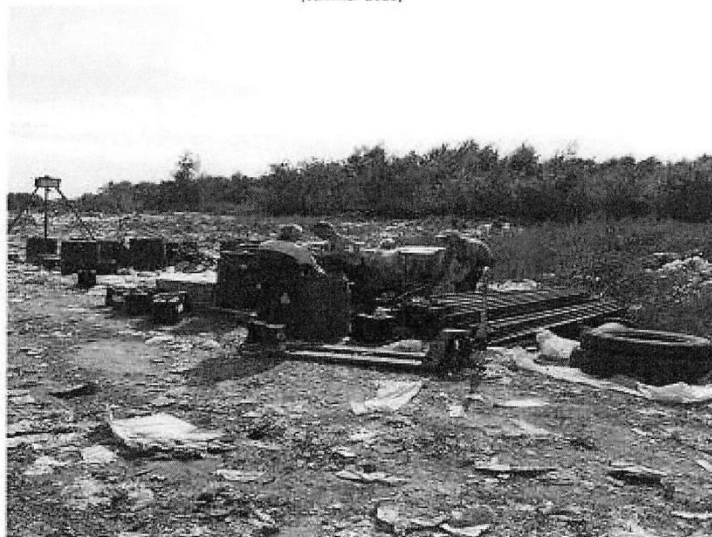
Tareas de preparación in situ de la solución biológica que se aplicará al terreno bio-remediado
