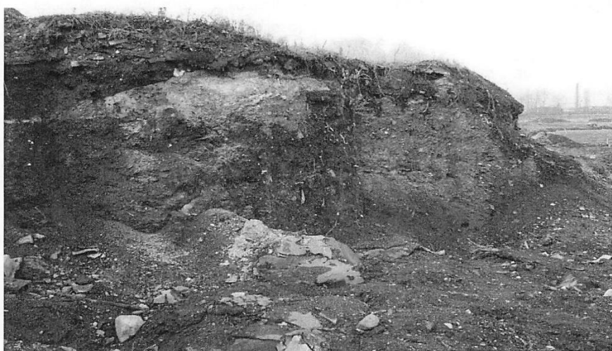
Corte seccional mostrando la profundidad de los residuos depositados para someterlos a la bio-remediación.
