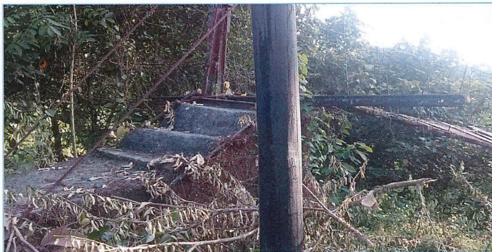
Figura N°1. Bastión margen izquierda aguas arriba
