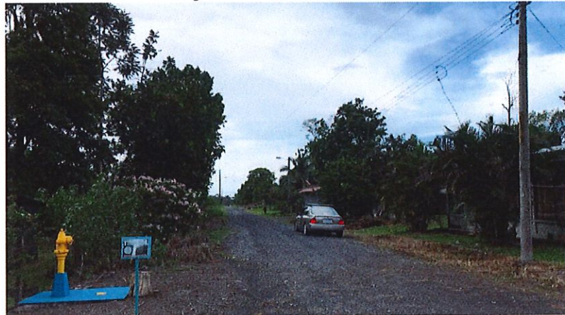
Figura 12.- Condiciones del acceso
