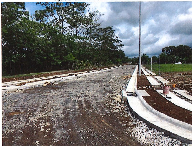
Figura 6.- Condiciones actuales del acceso
