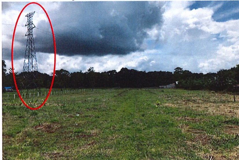
Figura 18.- Condiciones actuales del acceso
