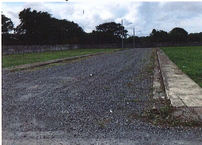
Figura 2.- Condiciones del acceso
