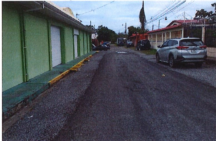
Figura 11.- Estado actual del camino
