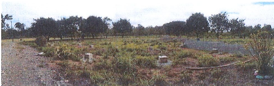
Ilustración 1 Área general de construcción
