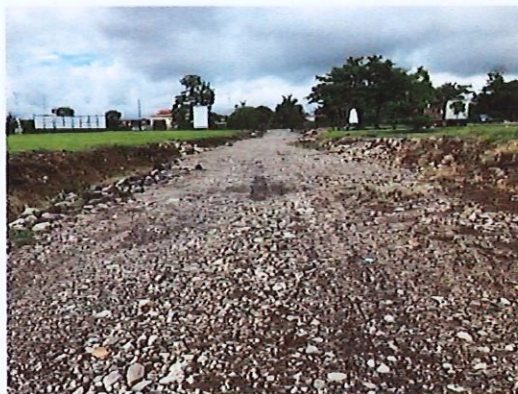
Foto 5: Sector de la Fase 2 listo para iniciar en cualquier momento, vista al sur.
