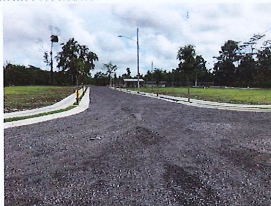
Foto 1: Obras ya finalizadas de aceras, caños, calle de lastre que solo falta asfaltar con postes y sistema eléctrico y alumbrado colocado.
