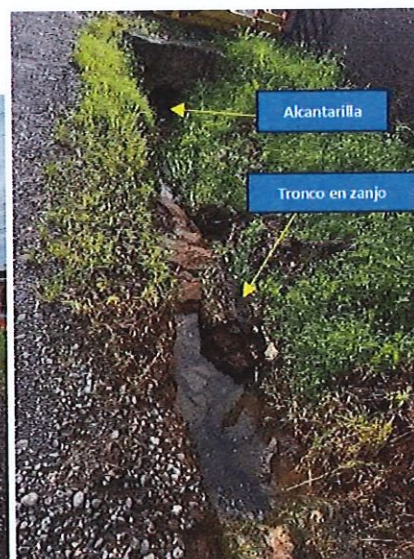
Fotografías 4 y 5. Situación actual del costado norte del lote esquinero con calle hacia el este, el zanja requiere mantenimiento de limpieza y quitar el tronco que pone en riesgo la obstrucción de la alcantarilla que puso el vecino Sr. Marvin Picado.
