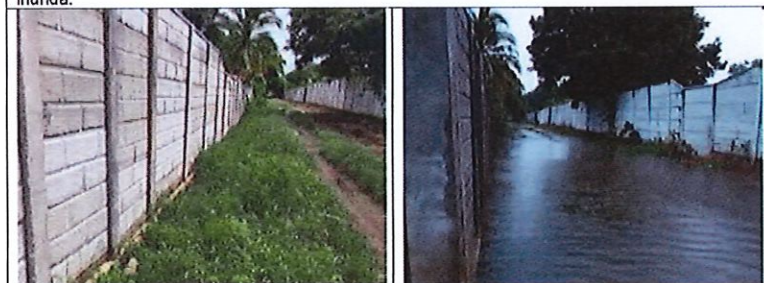
Figura 3 En una propiedad se levantó un muro; que según declaración de los vecinos aumenta el nivel de los anegamientos.
