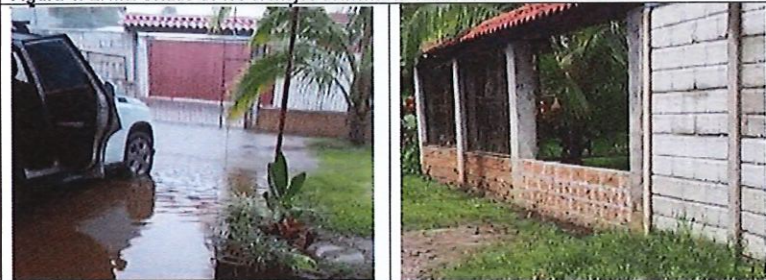
Figura 5. Unos vecinos han tenido que colocar estructuras en la entrada de las cocheras para evitar que el agua ingrese a sus viviendas.
