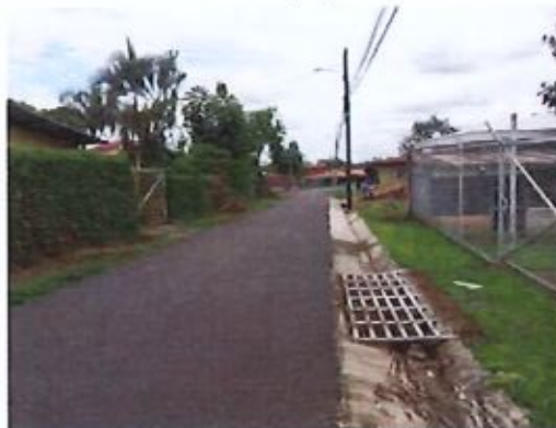
Imagen 2. Fotografía de la longitud que posee cordón y caño
