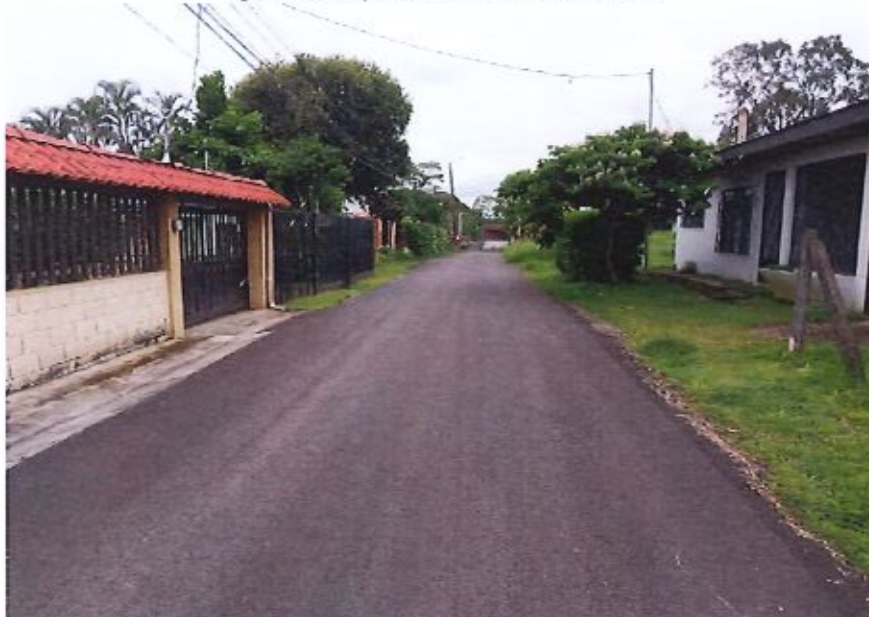
Figura 2.- Calle pública a recibir – Calle Manantial
