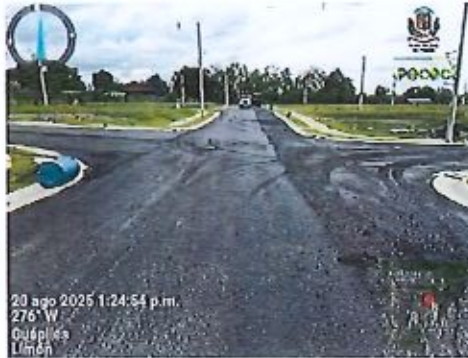
Imágenes de proyecto durante el proceso, construcción de carpeta asfáltica
