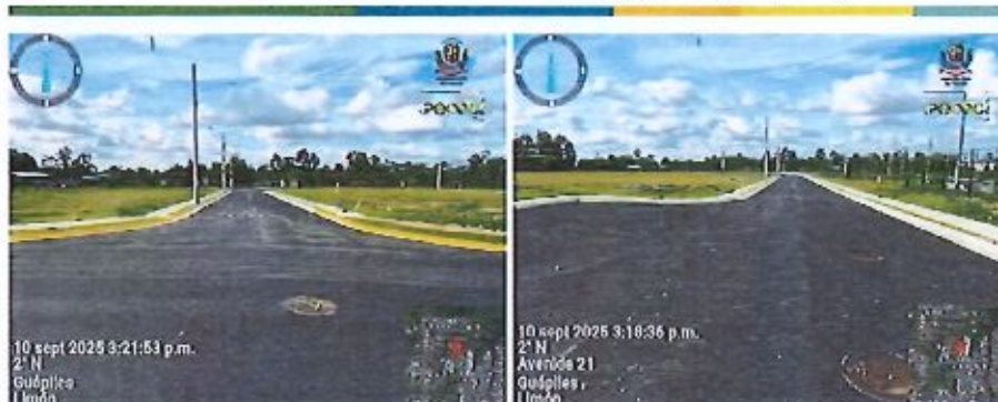
Imágenes de proyecto finalizado, construcción de carpeta asfáltica.
