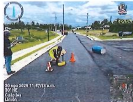
Imágenes de control de la calidad, construcción de carpeta asfáltica
