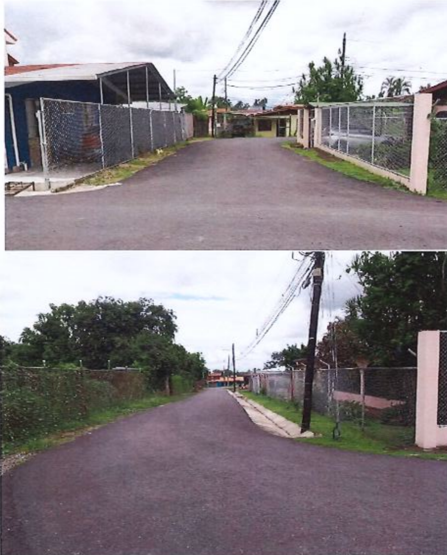
Figura 1.- Calle pública a recibir – Calle Manantial
