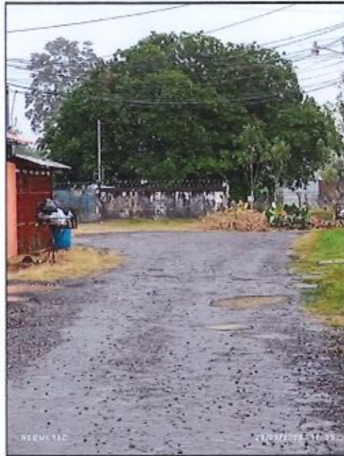
Fig. 2. Estado general de la calle. Falta de aceras, obstáculos para peatones, hoyos en la calle.
