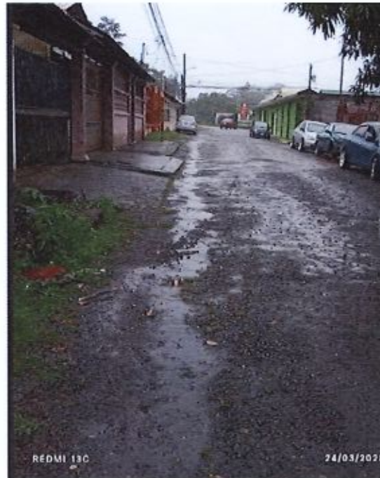
Fig. 4. Agua de lluvia corre libremente por la calle. Los peatones deben caminar en esta condición por no contar con aceras.
