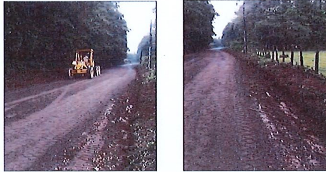
Figura 9 y 10. Mantenimiento rutinario de la ruta
